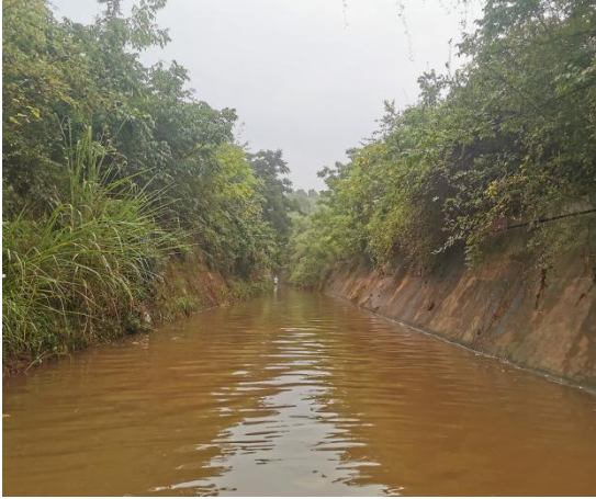
渠道底板砼衬砌段
