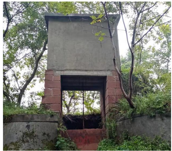
拆除重建 4+320 处泄洪闸
