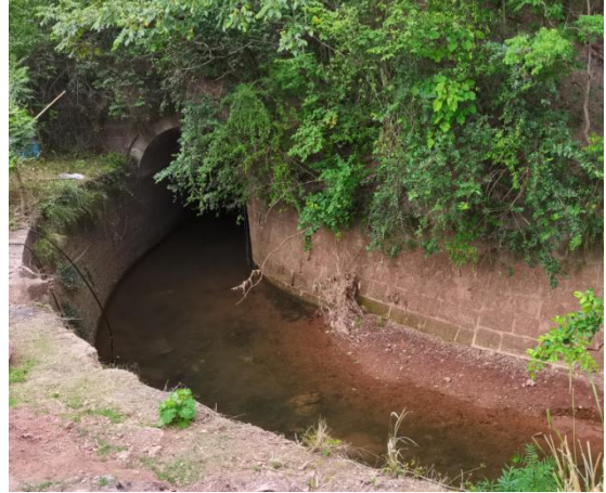
渠道底板砼衬砌段
